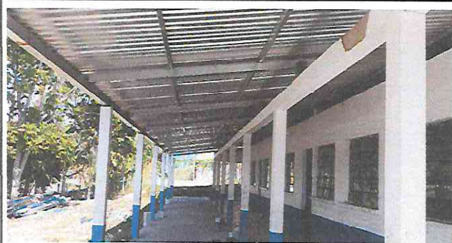
Foto 1: Así quedó la instalación de láminas de la escuela del Módulo 1
