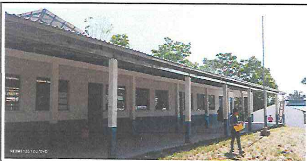
Foto 5: Imagen nuevas de instalación de costaneras, tijeras, cargaláminas y láminas troquel calibre 26.
